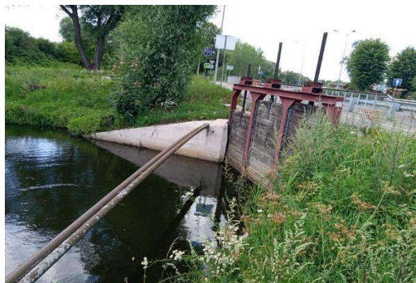
Рисунок 1 – Шлюз-регулятор на р. Товарной на ПК3+24 (из личного архива автора)
