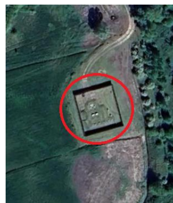
Рисунок 7 – Очистные сооружения поселка Новый, вид сверху
