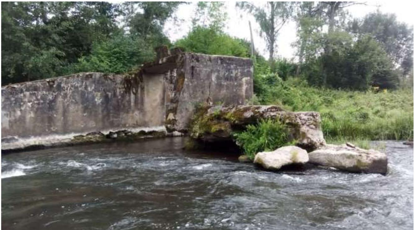
Рисунок 5 – Остатки конструкции ГЭС (плотины)
