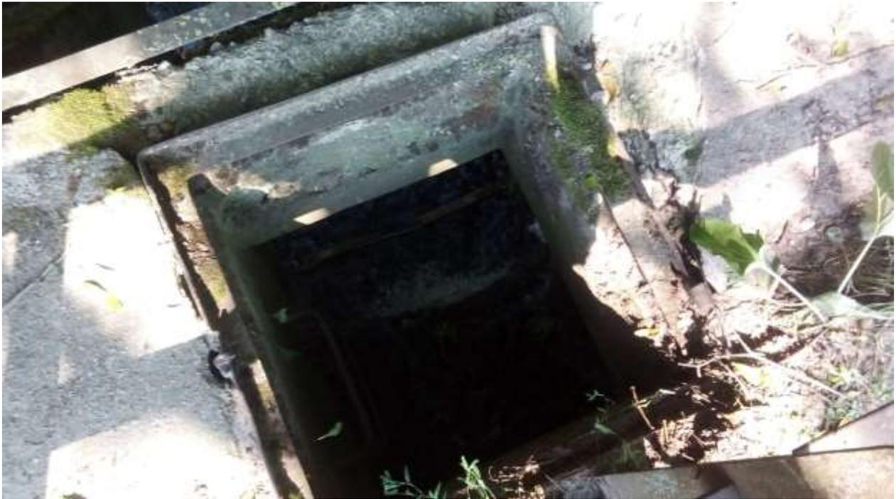
Рисунок 10 – Смотровой колодец над водобросным сооружением
