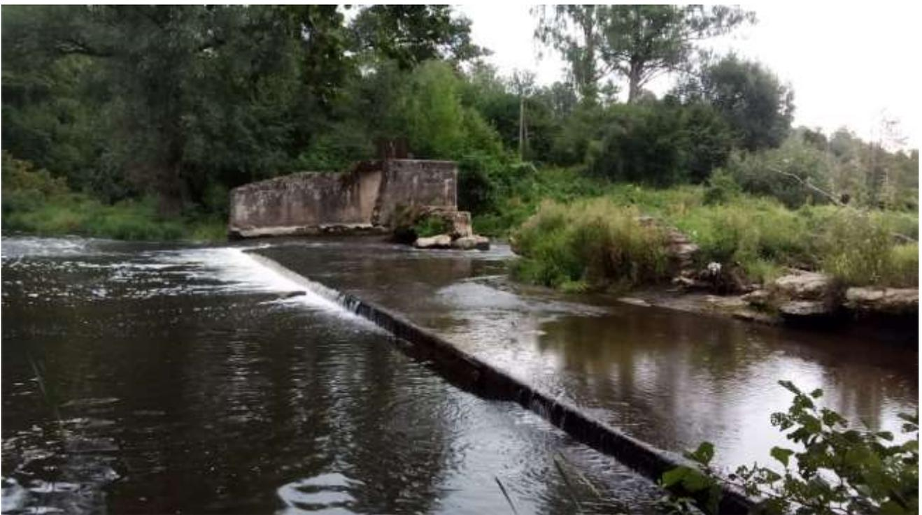
Рисунок 7 – Фрагмент плотины, водобойное сооружение
