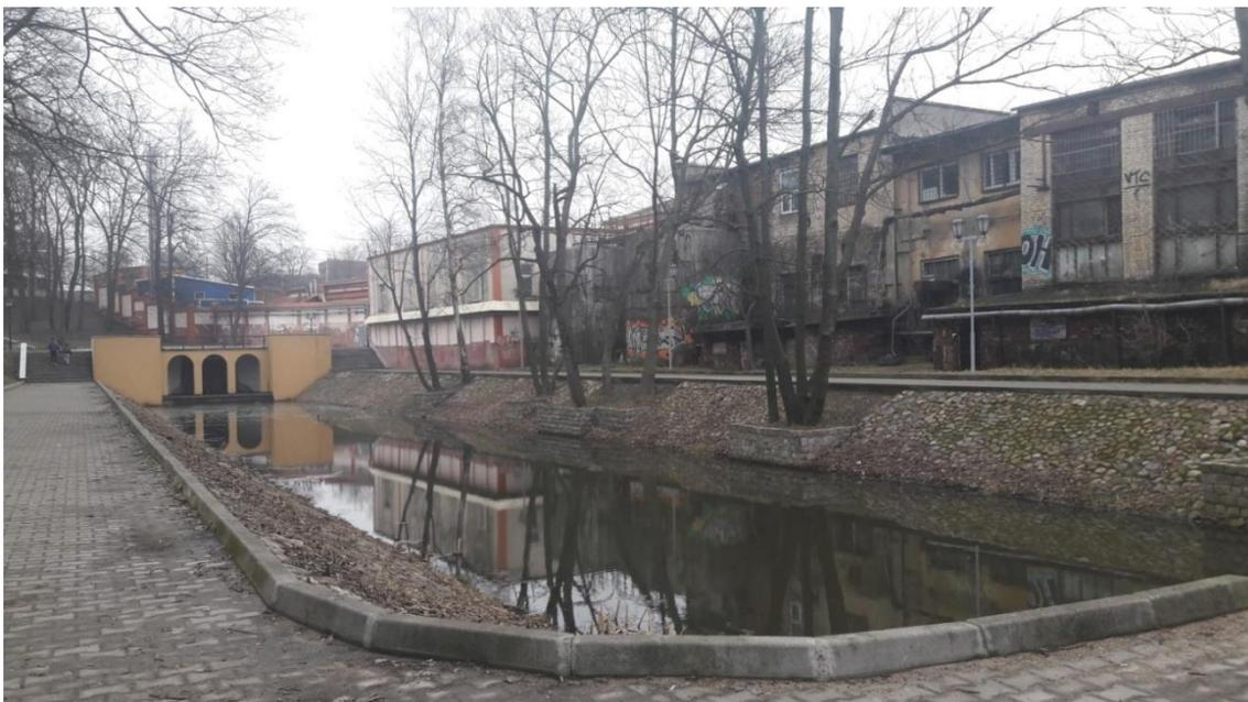
Рисунок 2 – Пруд Нижний (участок в виде трапецидального канала)
