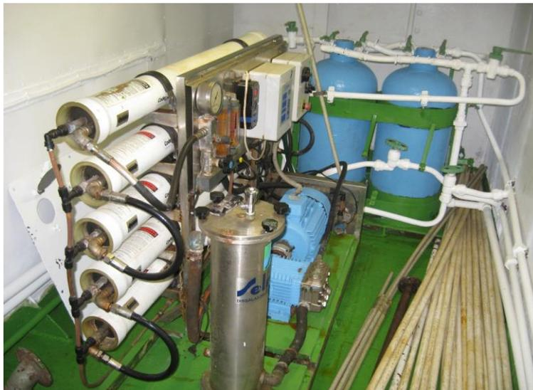
Рисунок 2 – Общий вид опреснителя SELMAR SW 1000 УПС «Крузенштерн»
